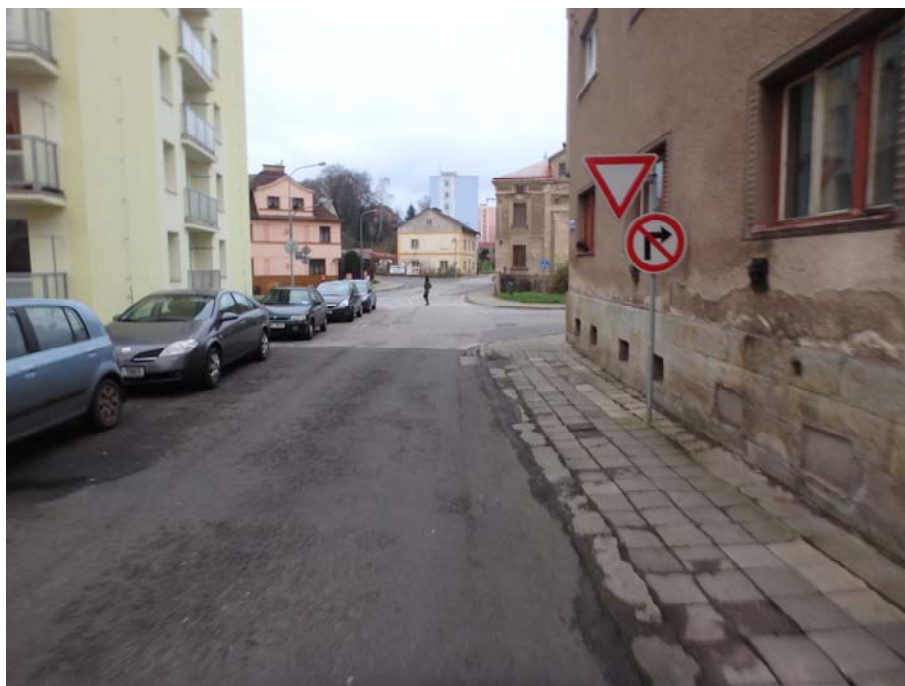
Foto 10 – Ulice Kryblická, západní, obousměrná část ulice, křižovatka s ulicí J. Wolker. Patrné je porušování dopravní předpisů odstavenými vozidly v křižovatce.
