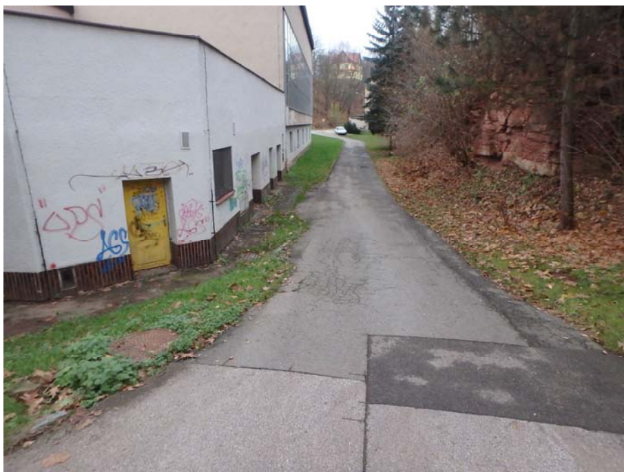
Foto 13 – Ulice Úvoz, úsek za plaveckým bazénem mezi ulicí Kryblickou a ulicí Svažitou.
