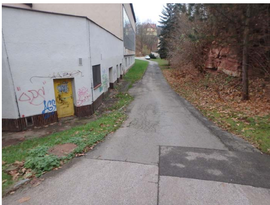
Foto 13 – Ulice Úvoz, úsek za plaveckým bazénem mezi ulicí Kryblickou a ulicí Svažitou.
