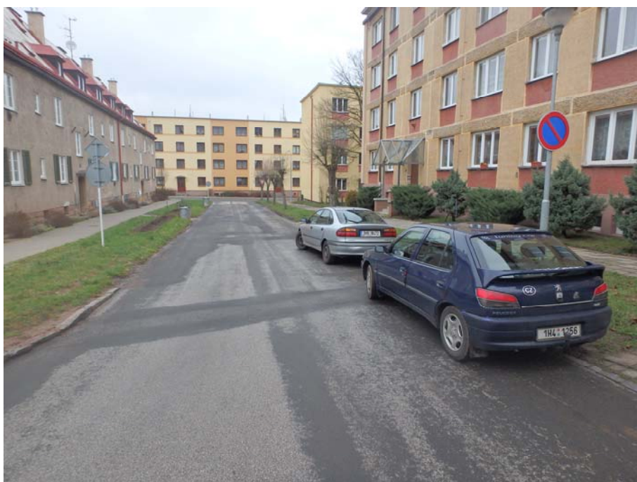
Foto 27 – Ulice Bratří Čapků, úsek mezi ulicí S. K. Neumanna a ulicí M. Gorkého. Zjevné je porušování dopravních předpisů odstavenými vozidly.
