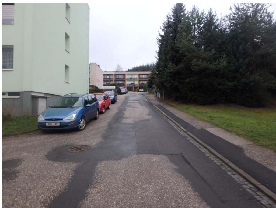
Foto 25 – Ulice Vítězslava Nezvala, úsek mezi ulicí M. Pujmanové a ulicí B. Němcové.
