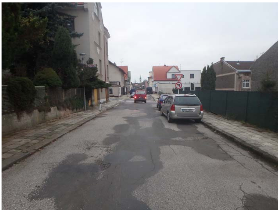
Foto 18 – Ulice Ivana Olbrachta, úsek mezi ulicí J. Wolkeru a vnitroblokem.
